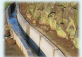
素堀り水路からの更新
