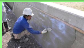
老朽化した水路壁のコーティング
