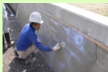
摩耗した水路壁への表面被覆材の塗布
