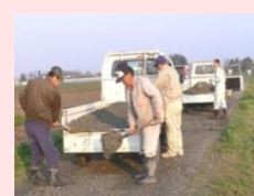
農道の法面維持
