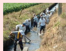
水路の泥上げ
