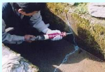
水路のひび割れ補修
