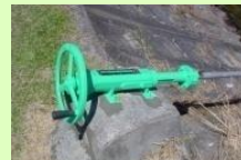
ゲート・バルブの更新
