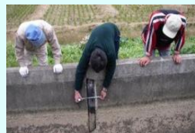
施設の機能診断
