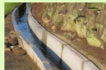
コンクリート水路の更新
