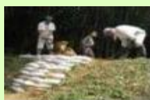
漏水箇所の補修
