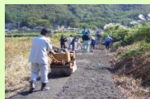
未舗装農道の舗装
