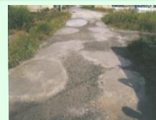
農道の窪みの補修
