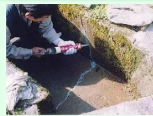
水路のひび割れ補修
