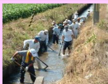
水路の泥上げ
