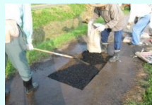
農道の部分補修
