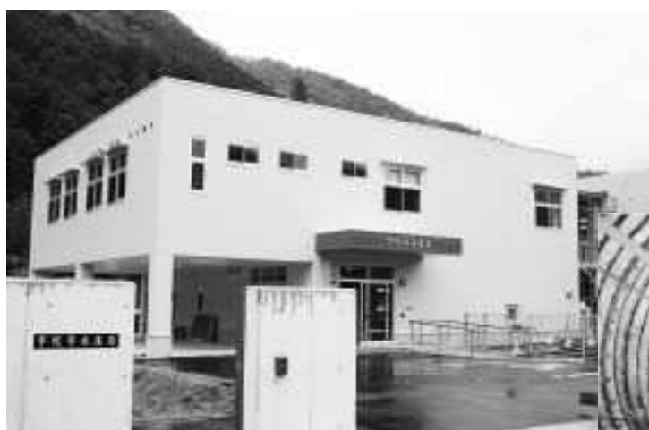
水道局舎増築
