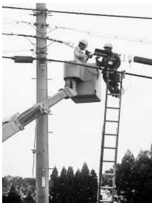
ケーブルテレビの工事
