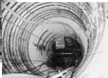
下水道管理設工事
