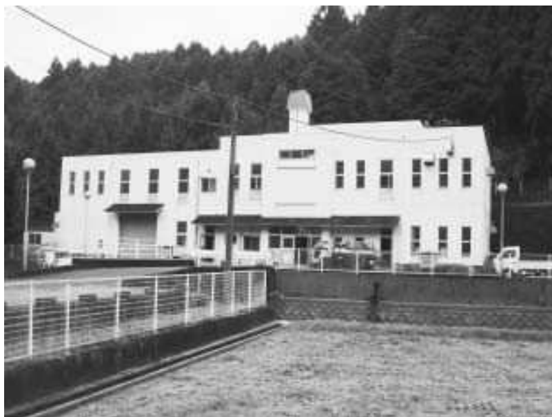
宇陀衛生センター
