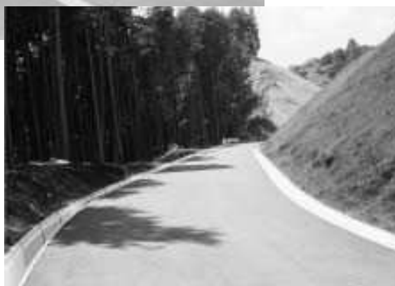
道路改良工事
