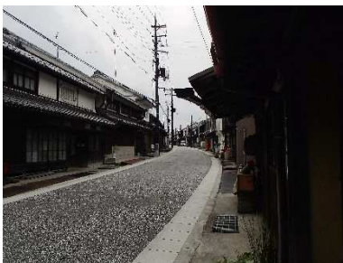
宇陀松山（重伝建地区）松山通り
