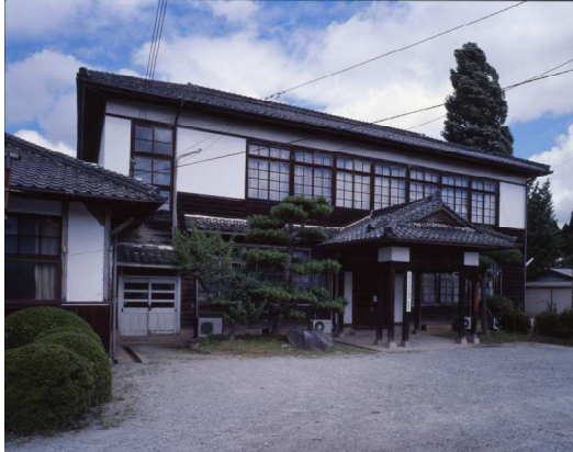
旧蚕業試験場の外観
