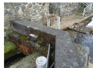
万六裏の堰と水門
