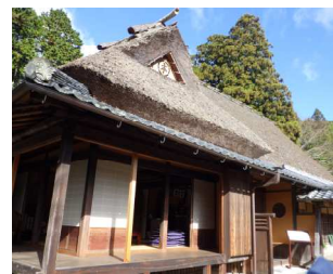
片岡家住宅主屋（客室部）
