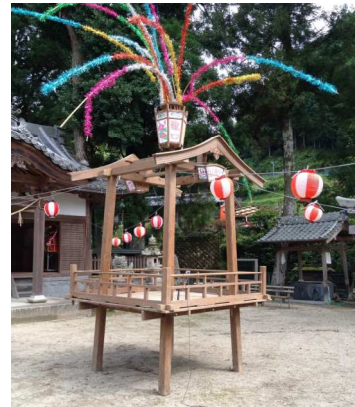
組立て中の音頭台※2
