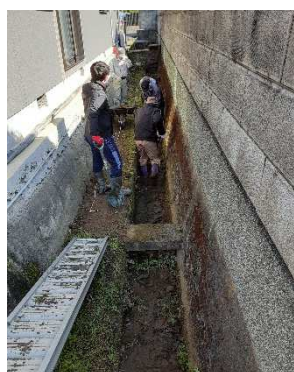
水路の泥揚げ作業
