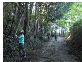
支障木の撤去や草刈りをする
