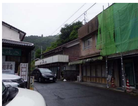
空き店舗の老朽化が進んでいる（室生）
