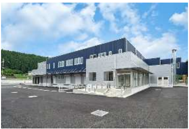
2024年7月に竣工した新学校給食センター
