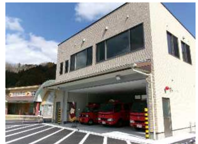
室生上笠間に建設された消防機庫
