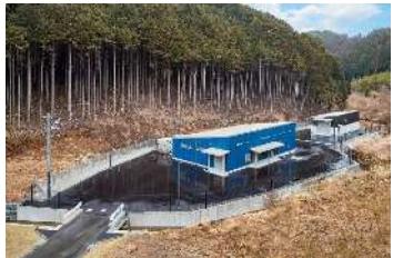
2024年2月に竣工したUDA GIBIER FACTORY
