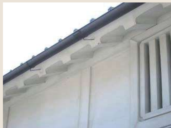
B 大屋根の軒裏 (1) 垂木の周りが曲線的
