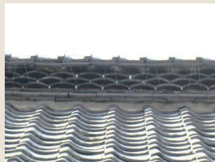
C 棟込み瓦が青海波 (15)
