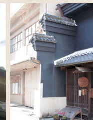
N 昭和 (17) 屋根の上にある袖卵建
