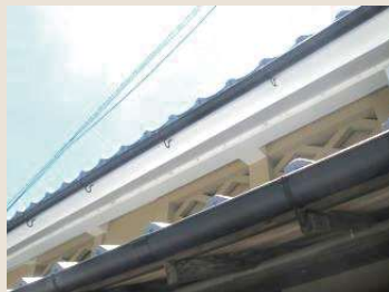
E 大屋根の軒裏 (18) 板軒
