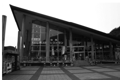
道の駅「宇陀路室生」
