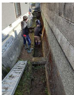
水路の泥揚げ作業
