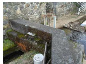
万六裏の堰と水門
