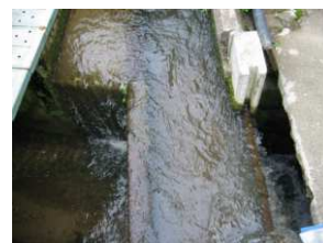
前川と山側から注ぐ水路の立体交差
