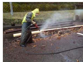
高圧洗浄機で皮を剥く
