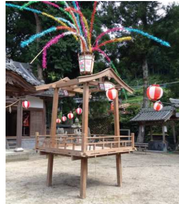
組立て中の音頭台※2
