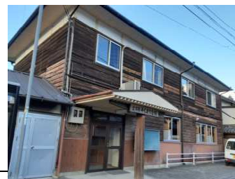
古市場みくまり会館 外観
