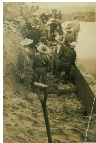
河川拡幅工事の風景（年代不詳）
