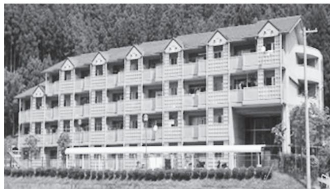
▲公営住宅 笠神団地
