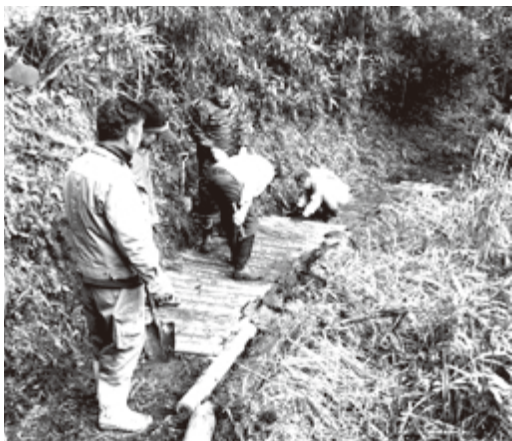
▲伊勢街道の補修作業中
