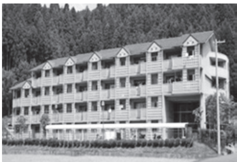
▲公営住宅 笠神団地
