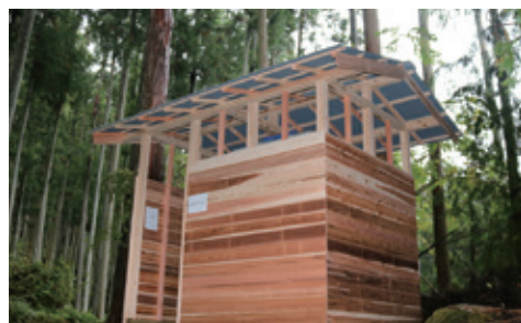
登山道に設置した簡易トイレ
