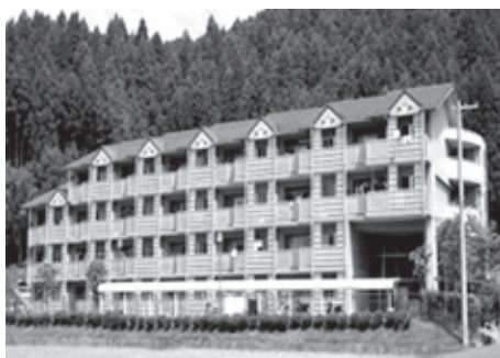
▲公営住宅 笠神団地
