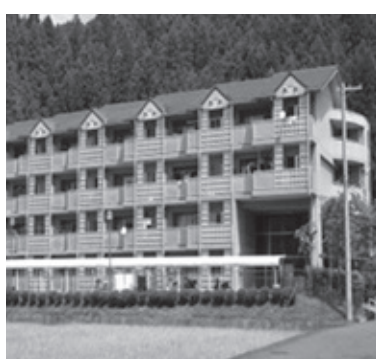
▲公営住宅 笠神団地
