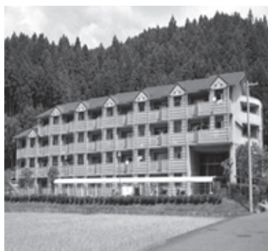
▲公営住宅 笠神団地
