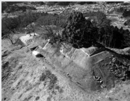
▲上空から見る宇陀松山城跡の天守・本丸
