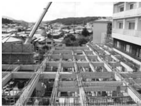
建設中の外来棟の様子 (東側からの撮影)
