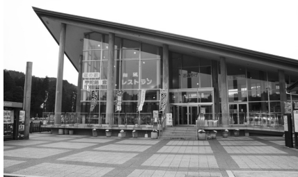
道の駅「宇陀路室生」
