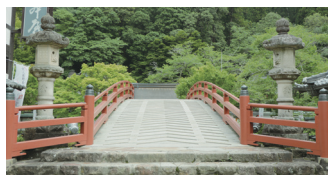
▲太鼓橋 改修前
