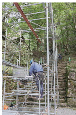
▲資材運搬のためのモノレール設置の様子
