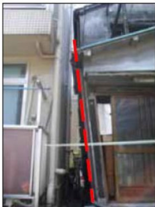
建物の傾きが明らかに確認できる例 (建築物の著しい傾斜)
