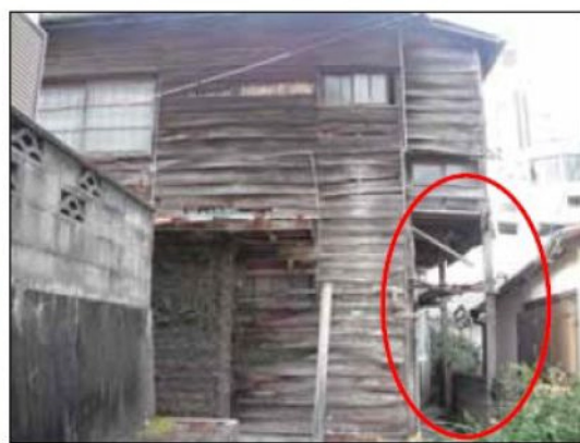
柱に局部的な亀裂やひび割れ等がある例 (柱、はり、筋かい、柱とはりの接合等)
