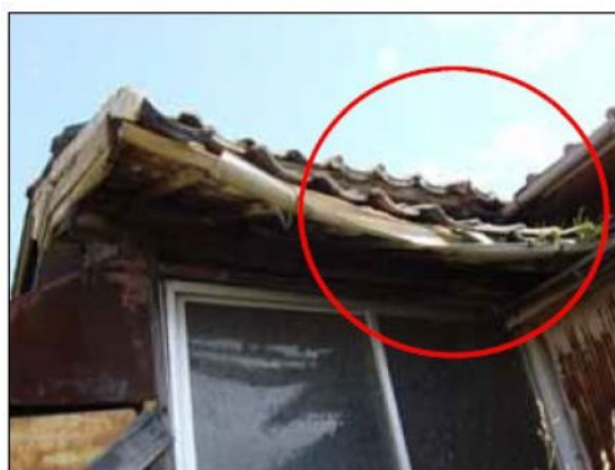
屋根が変形している、軒や雨樋が 垂れ下がっており、落下飛散の恐れがある例 (屋根ふき材、ひさし又は軒)
