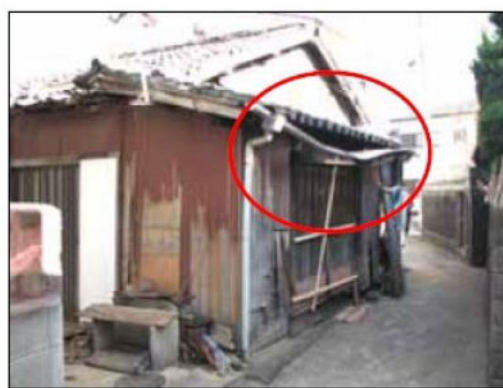
屋根が変形している、軒や雨樋が 垂れ下がっており、落下飛散の恐れがある例 (屋根ふき材、ひさし又は軒)
