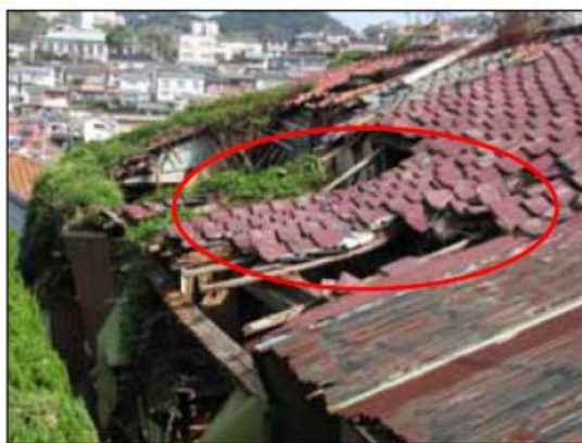
屋根、ふき材が剥落している例 (屋根ふき材、ひさし又は軒)
